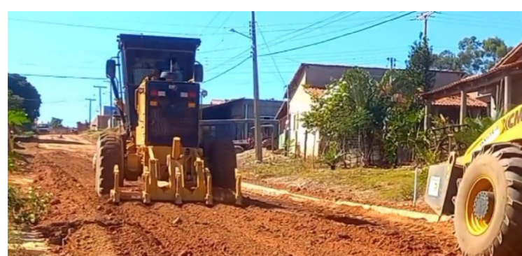
Serviços de drenagem no Setor Sudoeste, em Doverlândia - Foto: Comunicação/Prefeitura Municipal
